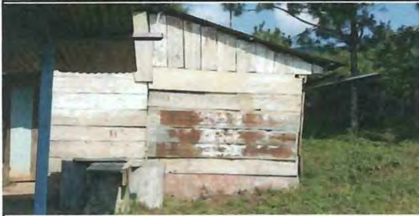
Foto1: IMAGEN DE EXTERIOR DE LA COCINA, CUENTA CON CIMENTO Y TRES FILAS DE BLOCK
