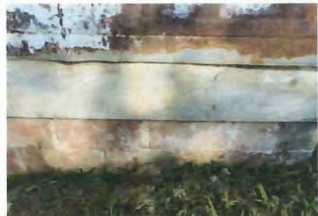
Foto 6: PARTE EXTERIOR CON DOS FILAS DE BLOCK
