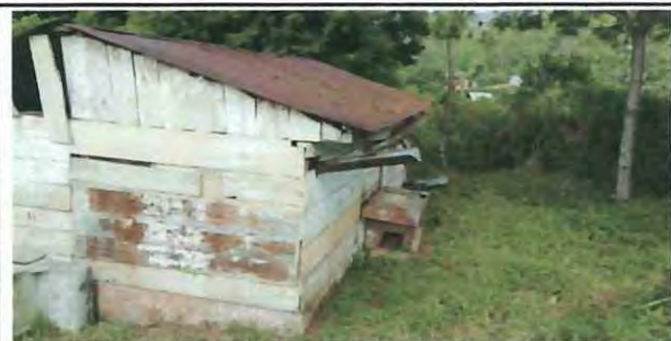
Foto 4: IMAGEN DEL EXTERIOR PARTE TRASERA DE LA COCINA
